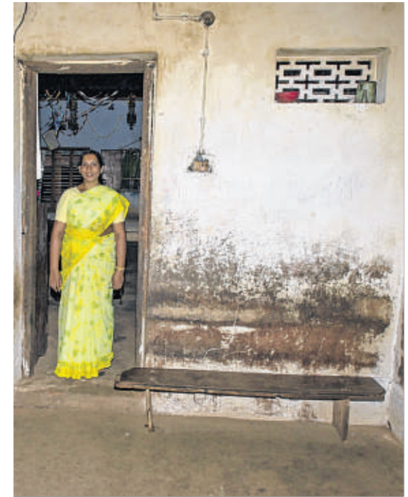
Kein Abstellraum, sondern ein durchaus üblicher Schulraum.
