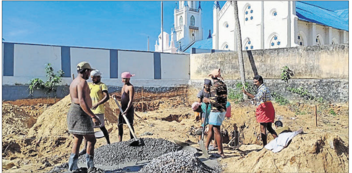
Neubau im Schatten der Kirche: In dem vom Zyklon heimgesuchten Dorf entsteht eine neue Schule.
